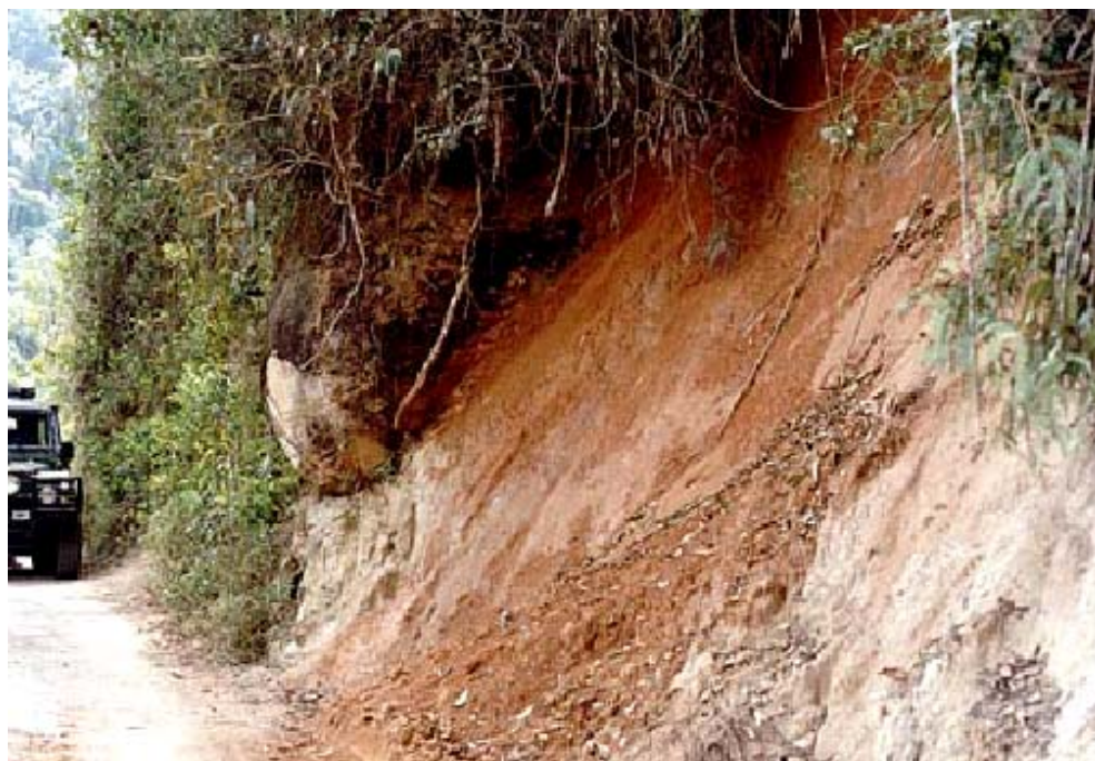
Figura 12 – Cicatriz de deslizamento em depósito de tálus, Vila do rio Itamarati.
